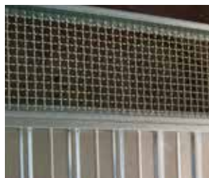
GRATE DI AREAZIONE consigliate solo su portoni in lamiera zincata
